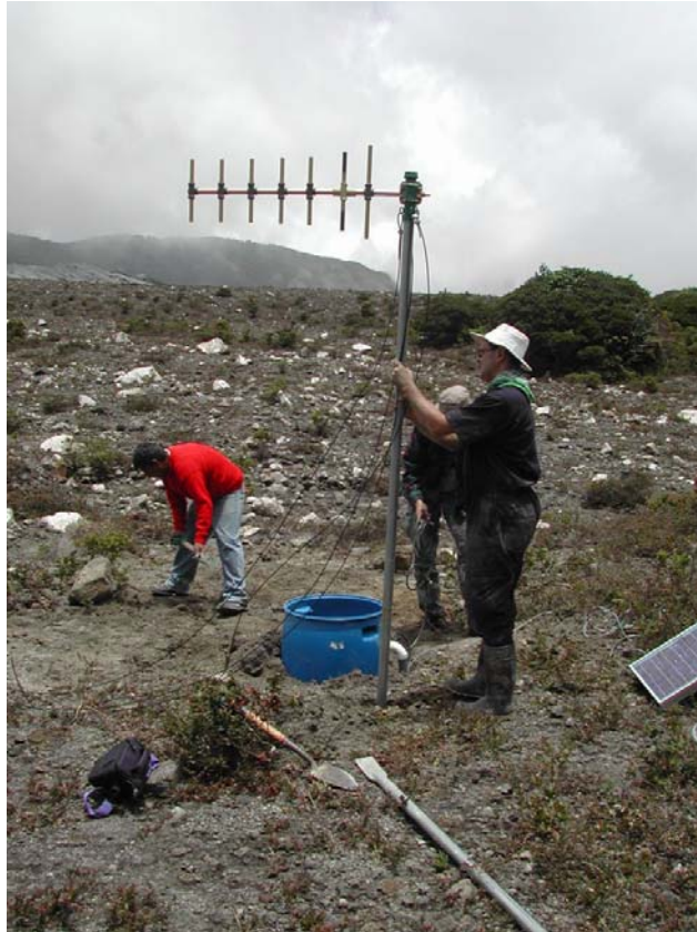
Foto: Construcción de estación sísmica von Frantzius (26-4-2006)
