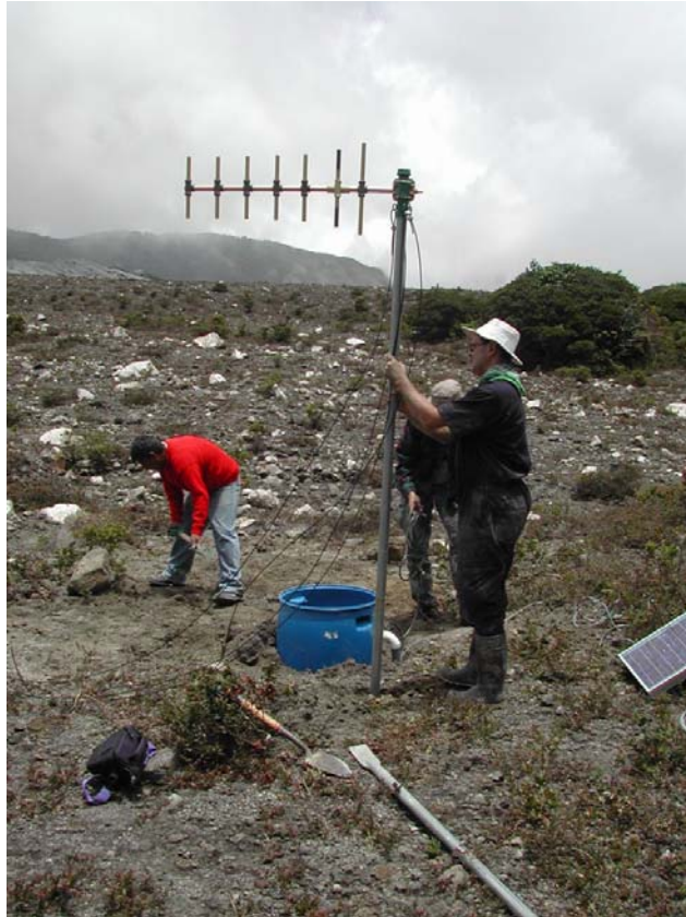
Foto: Construcción de estación sísmica von Frantzius (26-4-2006)
