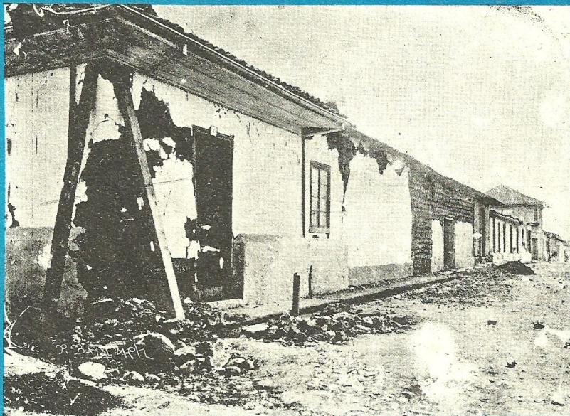
Casas dañadas en San José por el terremoto del 30 de diciembre de 1888 al norte de Alajuela. Nótese los daños principales en las esquinas. Tomado de: "Anales del Centro de Estudios Sismológicos de Costa Rica", 1911.
