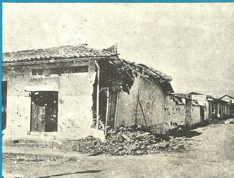
Casas dañadas en San José por el terremoto del 30 de diciembre de 1888 al norte de Alajuela. Nótese los daños principales en las esquinas. Tomado de: "Anales del Centro de Estudios Sismológicos de Costa Rica", 1911.
