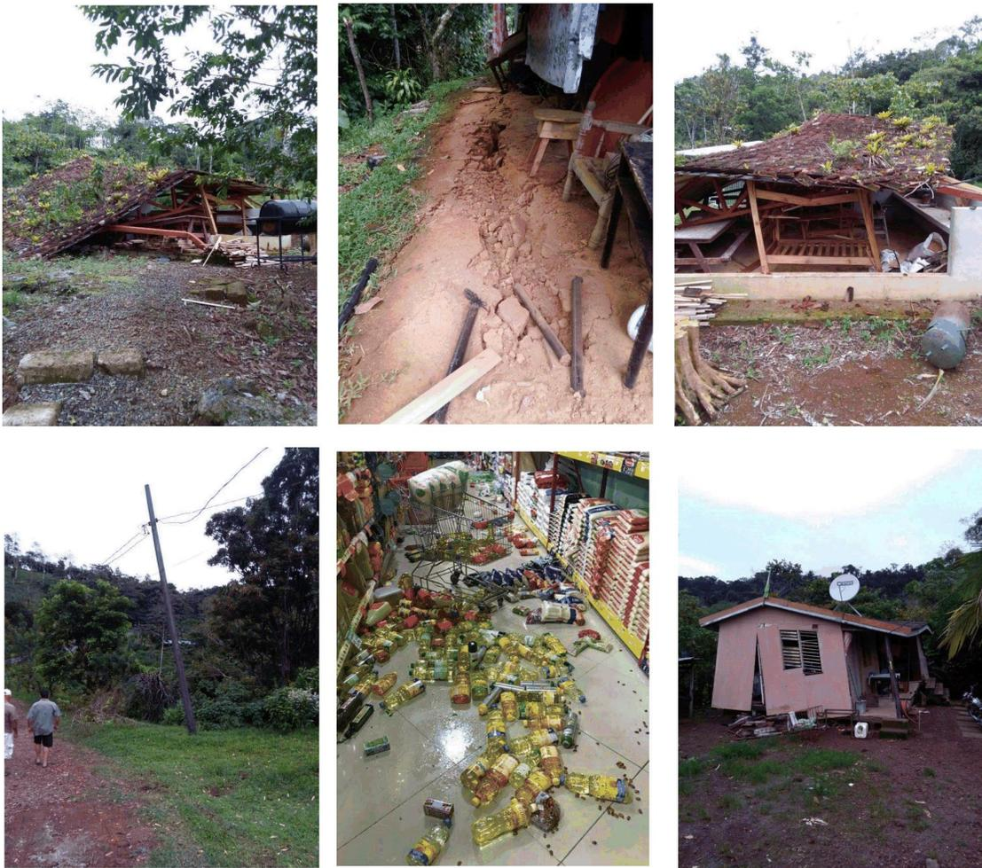
**Figura 6. Efectos del sismo en viviendas con métodos constructivos no adecuados, artículos caídos de las estanterías de los supermercados y grietas de deslizamientos en lugares cercanos a los cauces de los ríos.**
